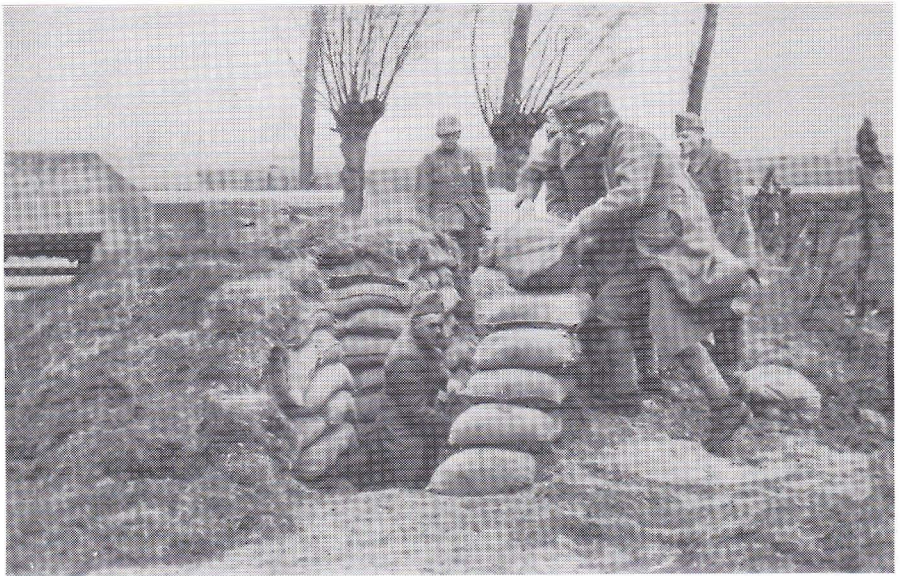
Mobilisatie 1939-1940: Stellingbouw in de vesting Holland
