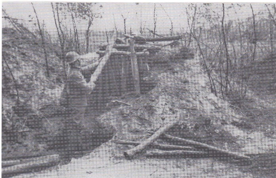
Mobilisatie 1939-1940: Stellingbouw in de vesting Holland
