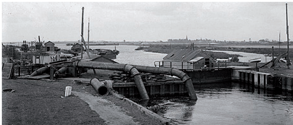
De Ballastsluis rond 1945.
