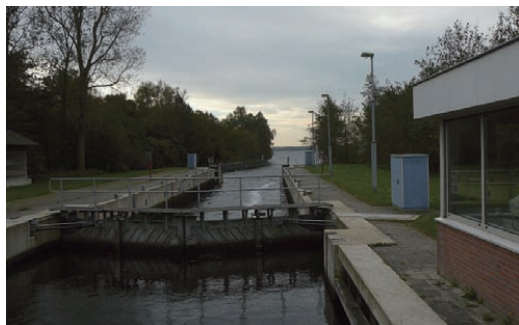
De Ballastsluis, doorvaart naar de Hinderdam.
