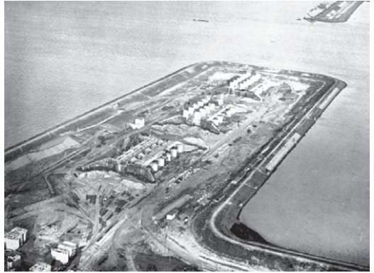
De sluisen bij Den Oever in aanbouw.
