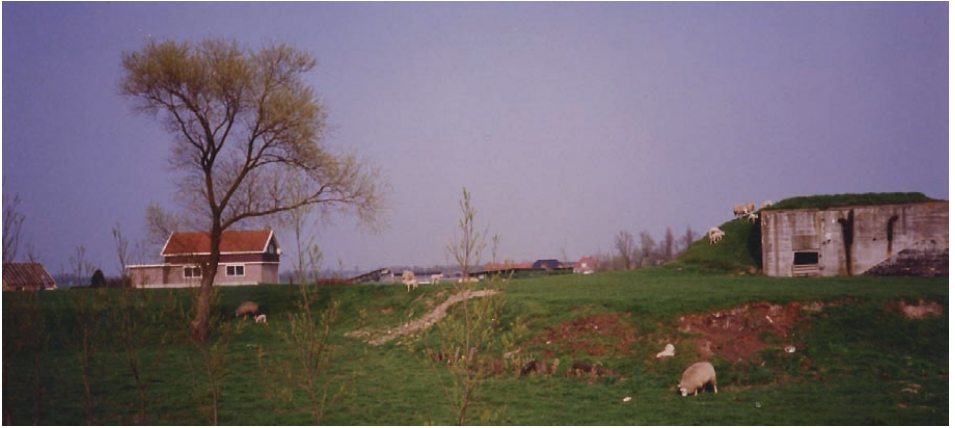
Een in 1935 gebouwde kazemat (Overmeer genaamd) om de verzwakking van de Nieuwe Hollandse Waterlinie door het graven van het Hilversumskanaal op te vangen.
