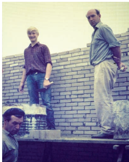
Cees met troffel bij de bouw van de Nederhorstkantine.
