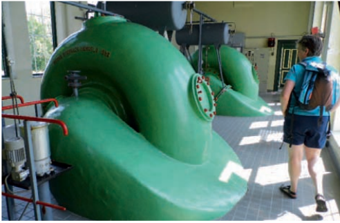
Het gemaal Demmerik (1923).
