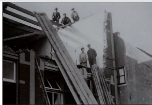
SLOOP VAN HET GESTICHT. OP HET DAK AANNEMER HEIN HENDRIKSE.
