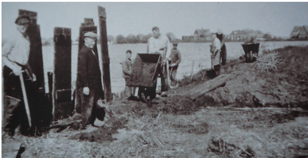
Het dichten van de dijk van de Hornpolder in 1945.
