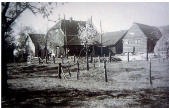
Achterzijde Hinderdam nummer 15 en 17.
