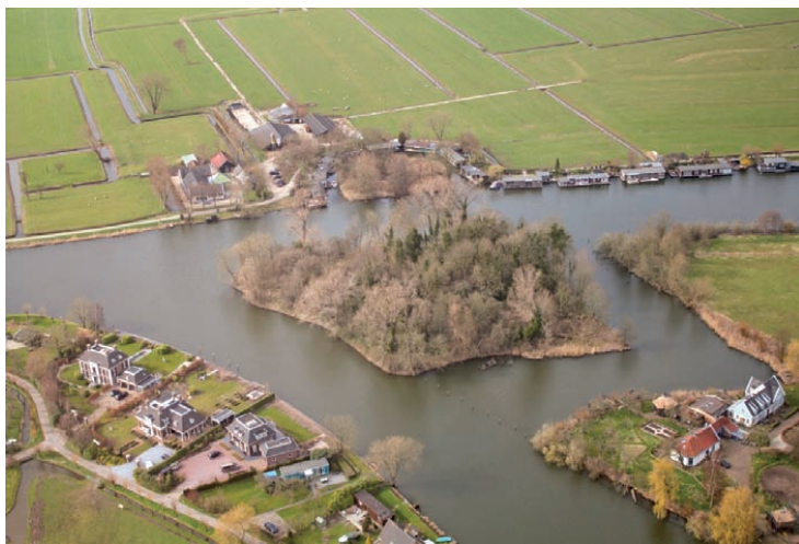
Fort Hinderdam vanuit de lucht.
