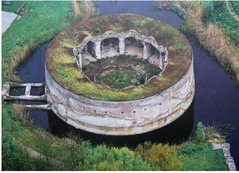
Het deels met een dak bedekte fort na de 'restauratie'. De bedoe- ling is er openluchttheatervoorstellingen te gaan uitvoeren.
