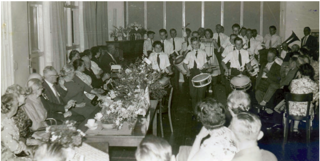
Deze foto uit het begin van de zestiger jaren, is genomen in het Hotel Café Restaurant van Thomas van der Meer. De Reevaart stroomde nog door het dorp, maar de oevers vertoonden al allerlei gebreken. Crescendo was vanaf begin vorige eeuw niet weg te denken uit het dorpsgebeuren. Er was constant jeugdige aanwas. Ze traden hier op vanwege het zestigjarig organistenjubileum van Arie Struik, samen met zijn vrouw Bertha Stofbergen. Ank Meijer gaf ons deze foto.
