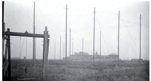
De ruitantennes staan al opgesteld.
