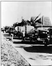
Wasserijzers op weg naar de nieuwe Spiegelbrug. Collectie HCNAH.
