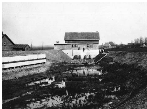
Het nieuwe elektrische gemaal gebouwd in 1924 is bijna gereed om het waterpeil in de Horstermeer polder op hoogte te houden, het boezemkanaal is aangelegd om het water in de Vecht te lozen
