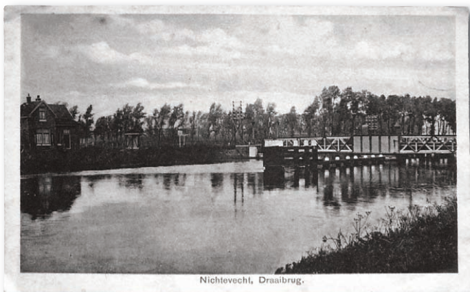
Foto 3. De draaibrug over het Merwedekanaal tegenover de Korte Velterslaan
