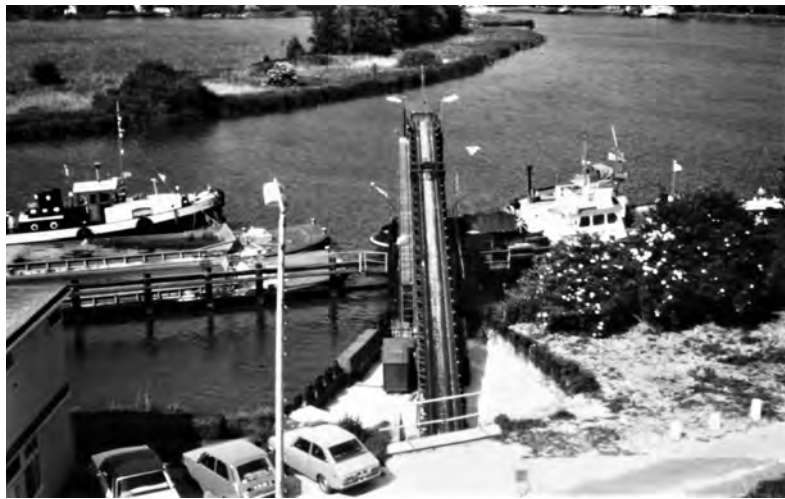
Een hulploopband vult achter elkaar het ene schip na het andere met droog zand. Dit komt uit een silo, die door een lange lopende band vanuit de elevator constant gevuld wordt.
