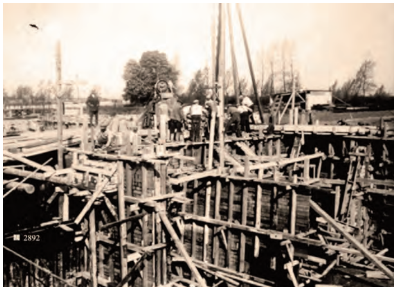
De bouw van de ophaalbrug 't Hemeltje
