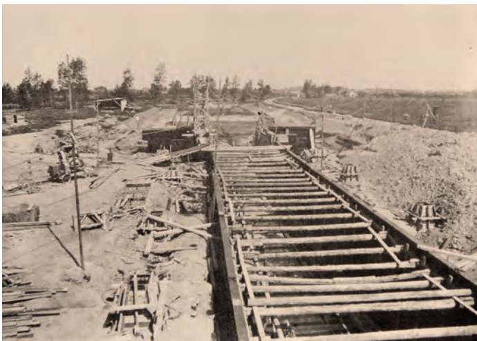
Het fundament van de sluis 't Hemeltje
