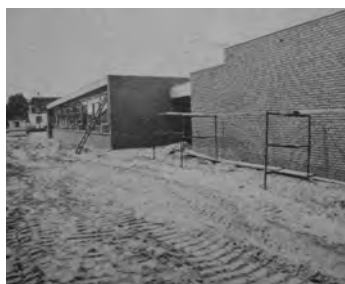
Zand voor de bouw van de Jozefschool in Nederhorst den Berg
