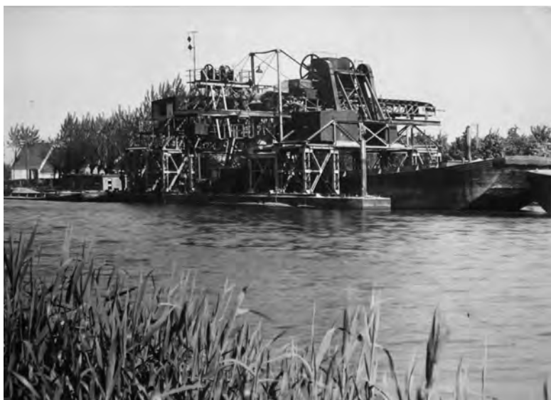
Dit is een elevator. Deze ligt vlakbij het Hemeltje en haalt het zand uit de bakken die op de Wijde Blik zijn gevuld
