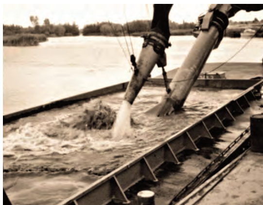
Gevuld en wel naar de sluis voor verder transport of naar de elevator. Een ingenieus systeem zorgde er voor dat het water onder het varen of al wachtend bij de elevator kon worden weggepompt. Dit zand diende om de wachtende schepen in de Vecht te kunnen vullen
