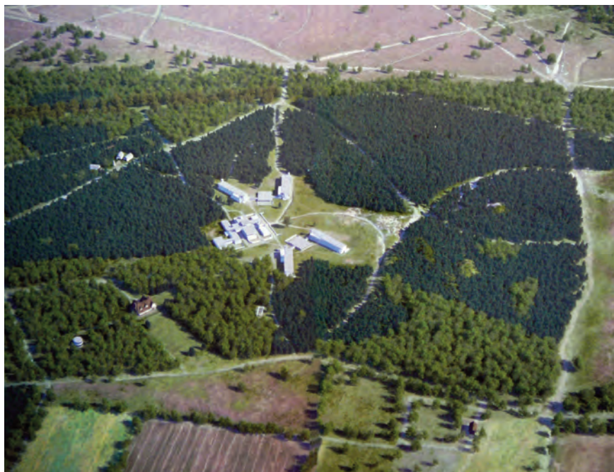
Sanatorium 'Zonnestraal' in een luchtopname, circa 1931. Linksboven het complex staan de werkplaatsen
